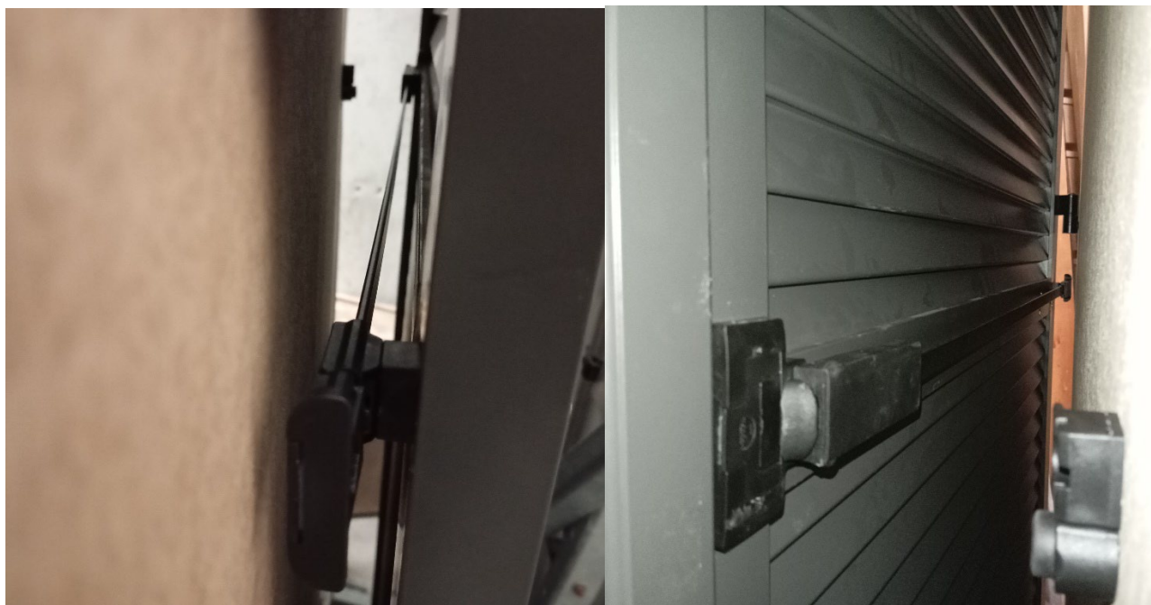
Figure 1 : système d'arrêt Ellipse monté sur un volet battant
